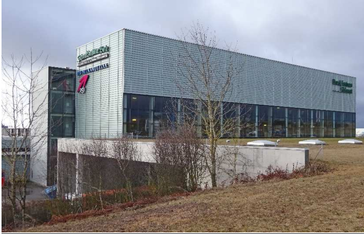
Druckzentrum Südwest in Villingen-Schwenningen, Germany
